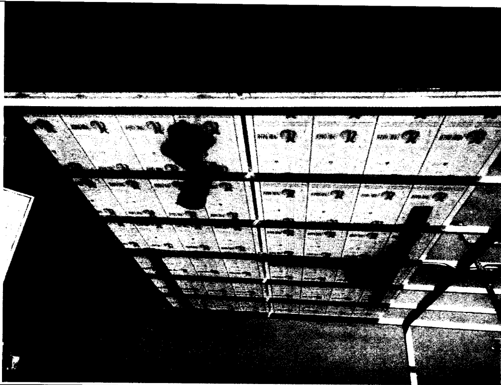
Imagen N° 03: En la presente imagen se puede observar los trabajos de instalación de cobertura de policarbonato.
